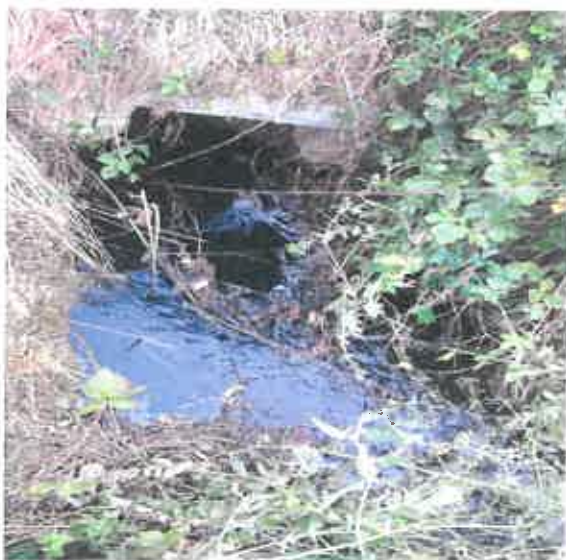
Slika 18: Iztok požarne vode na lokacijo NM01
