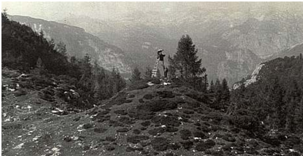
Slika 5. Vzdrževalna dela na totalizatorju na Zadnjem Voglu – Šiji leta 1965 (arhiv ARSO) Figure 5. Maintenance of totalizator - huge rain gauge in Zadnji Vogel – Šija, photo taken in 1965 (archive ARSO)
