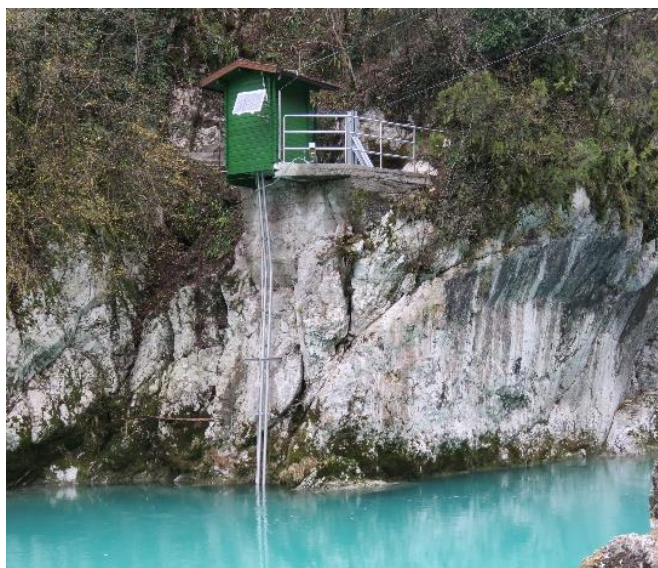
Slika 2. Hidrološka postaja Soča Kobarid. Merilno mesto je opremljeno z vodomerno letvijo, avtomatskim tlačno-temperaturnim in radarskim senzorjem za izvajanje meritev pretoka in temperature vode. Merilno območje sega od 50 do 700 cm višine (foto: arhiv ARSO). Figure 2. Gauging station Soča Kobarid (Photo: ARSO archive)
