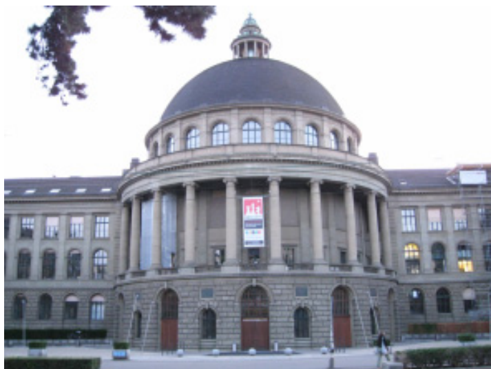
Slika 1. Konferenčni center ETH (foto: T. Cegnar) Figure 1. Conference centre ETH (Photo: T. Cegnar)
