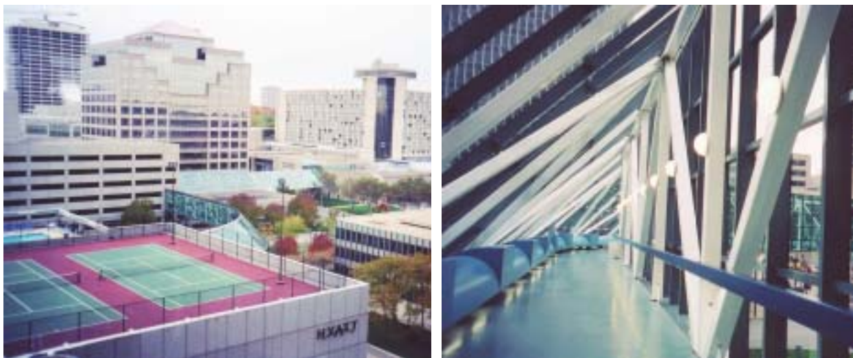
Slika 1.5.2. Hoteli, kongresni center in trgovski center ter železniška postaja so med seboj povezani s steklenimi hodniki, ki obiskovalcem omogočajo obisk navedenih objektov, brez da bi stopili na prsto
