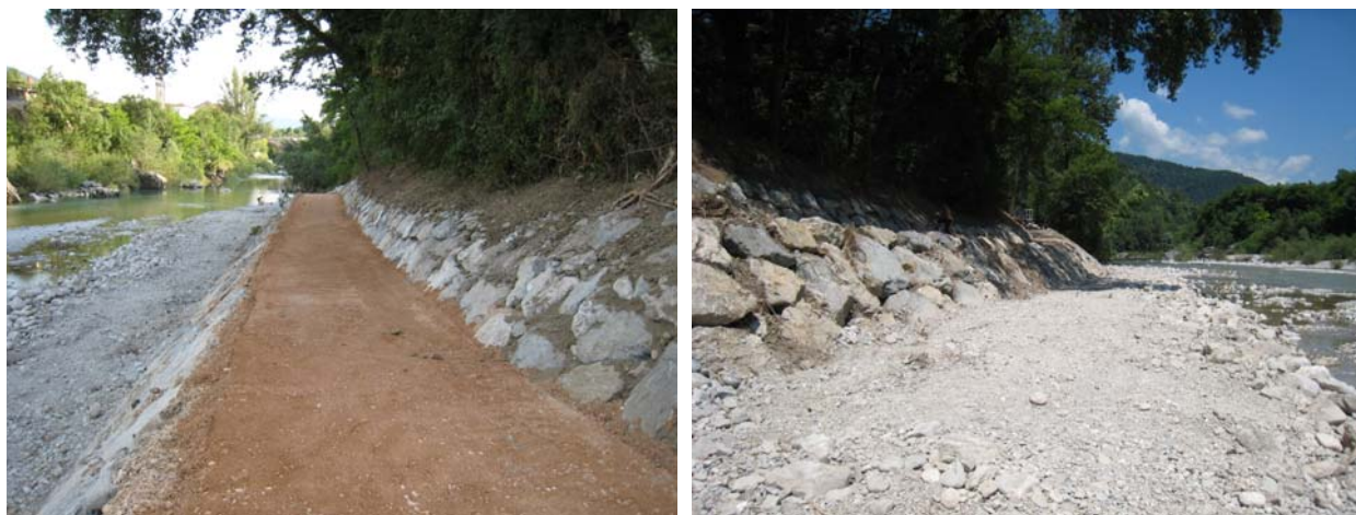
Slika 3: Izgradnja kamnometa
