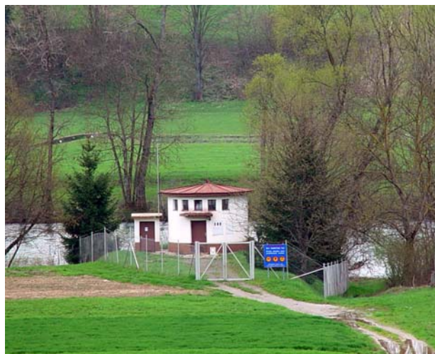
Slika 4.3.4: Črpališče na Kolpi
