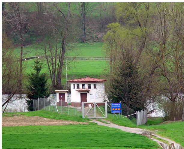
Slika 4.3.4: Črpališče na Kolpi
